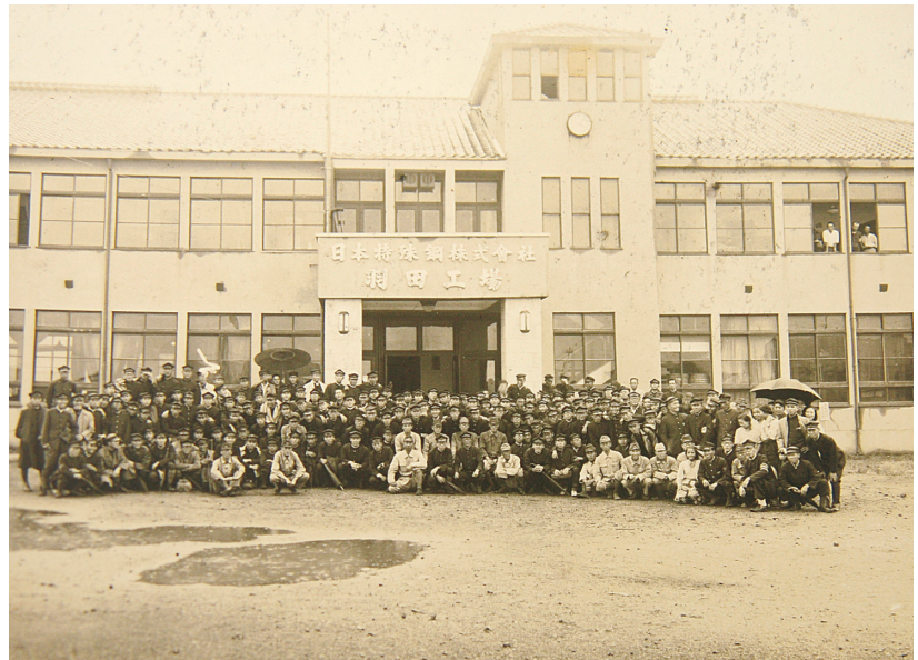
昭和19年6月～9月に専門部商科・経済科が動員された 日本特殊鋼株式会社羽田工場
